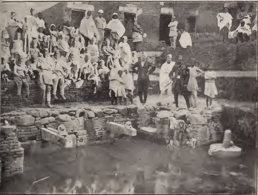
Hithi (fosse d'ablutions) à Patan.
